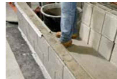
4. Après enlèvement des réglettes, le lit de mortier est parfaitement dosé
