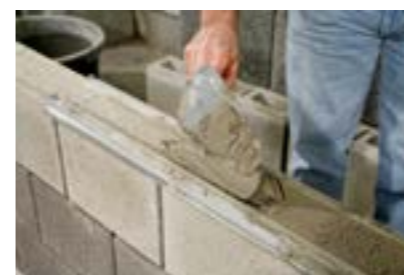
1. Dépose du mortier entre les réglettes de dosage
