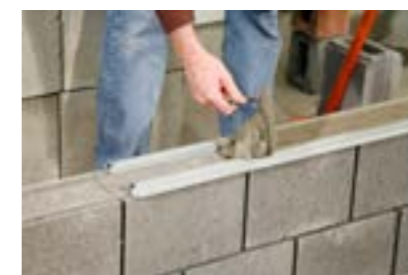
2. Arasement de l'excédant de mortier
