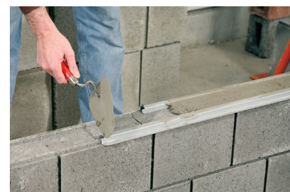
3. Déplacement des réglettes de dosage
