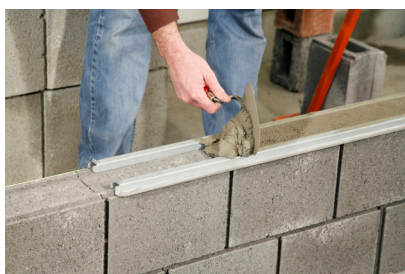
2. Arasement de l'excédant de mortier
